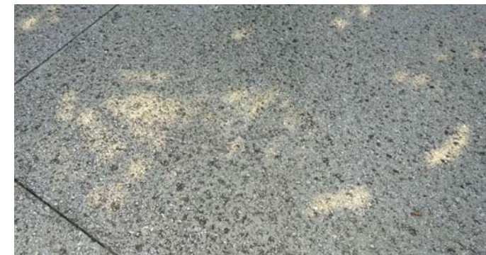
1.9 SALT VOID CONC. L3.0 Scale: 1" = 1'-0"
