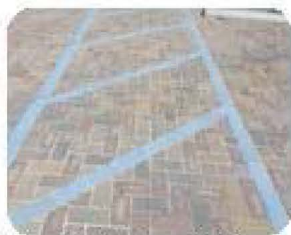
Blue ADA Paver Striping
